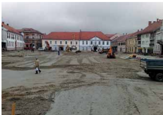
Glavni trg v Ljutomeru med obnovo
