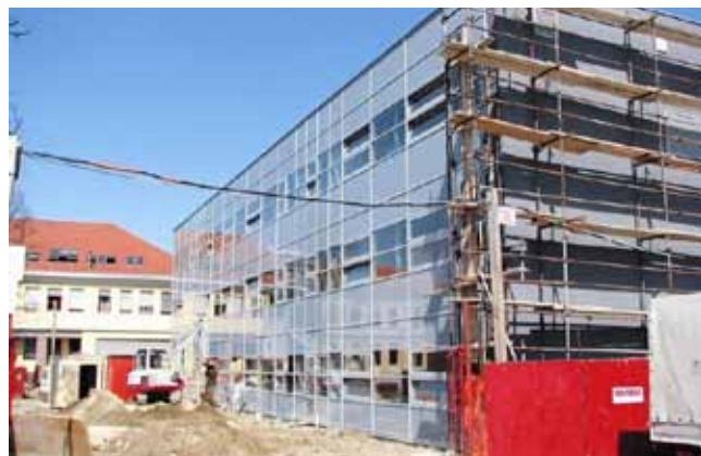
Športna dvorana pri Gimnaziji Franca Miklošiča Ljutomer v izgradnji
