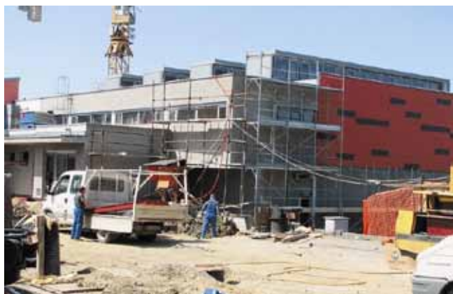
Vrtec in osnovna šola v Stročji vasi med gradnjo
