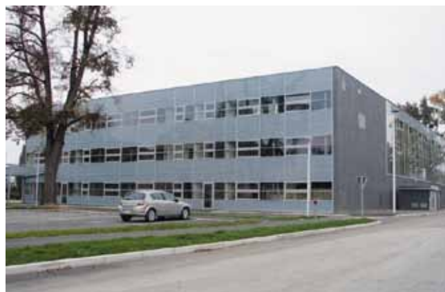
Dokončana večnamenska športna dvorana, novembra 2009
