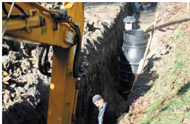
Izgradnja kanalizacije v Stročji vasi
