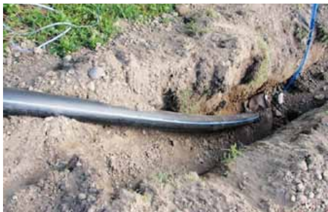
Nove vodovodne cevi iz sodobnih materialov
